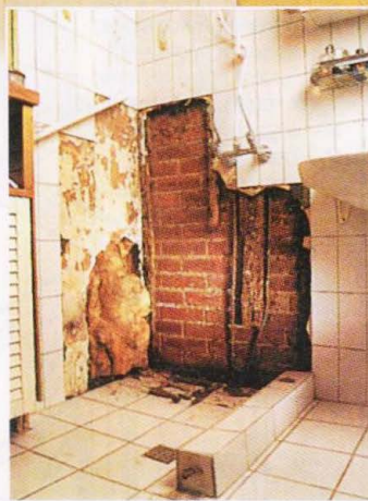
Ванная комната до и после ремонта. В обновлённой ванной душевая кабина отделена от остальной части помещения стационарной каркасной перегородкой, облицованной керамической плиткой.
