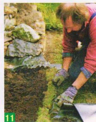
11 Края плёнки укрывают дёрном, снятым при рытье котлована. Выступающую из-под дёрна плёнку обрезают.
