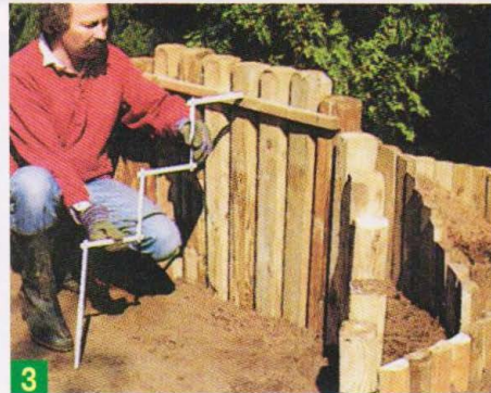
3 Поставленные ступенчато сваи замыкают с боков внутренний ряд. С помощью складного метра определяют, где закончится лестница и начнётся пруд.
