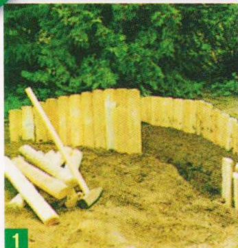
1 Грунт легко размывается водой. Поэтому холм с водопадом необходимо укрепить. На заднем плане — две стенки из кольев, вбитых в грунт полукругом.
