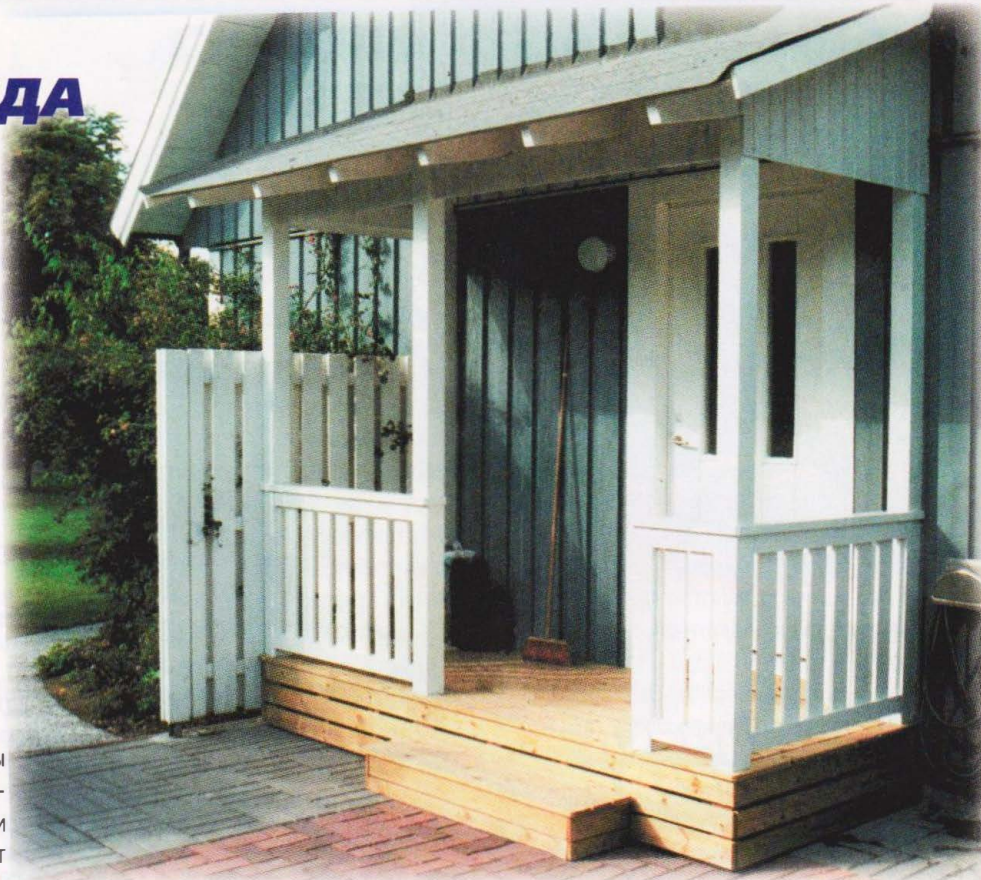
Эту веранду-малышку пристроили к дому со стороны глухого фронтона. Её крышу потом дополняют ещё черепицей, уложенной по обрешётке из кровельных реек, водосточным жёлобом из листового металла, ветровыми досками и уголками из листового металла (по боковым кромкам крыши).
