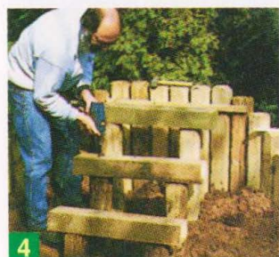
4 Ступени из кольев и брусьев под плиты каскада соединяют друг с другом на болтах, головки которых врезают в дерево, чтобы опорные поверхности под каменные плиты были гладкими.
