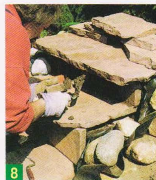
8 Кладку плит ступеней ведут на растворе, приготовляемом из сухой смеси. Плита на верхней ступени укрывает «исток» водопада — конец водяного шланга.
