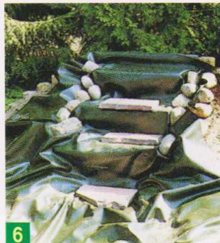
6 Плёнку ПВХ хорошо раскладывать в сухую солнечную погоду. На солнце она становится более пластичной и лучше принимает форму дна и ступеней каскада пруда.
