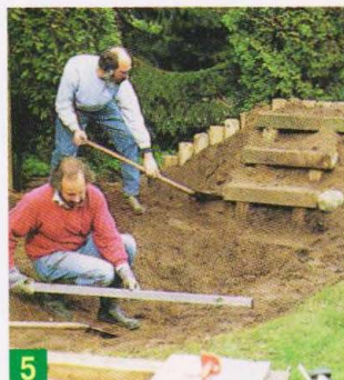
5 Вынутый при рытье котлована грунт отсыплют в холм. Время от времени следует проверять уровнем и рейкой-правилом высоту берега будущего пруда.
